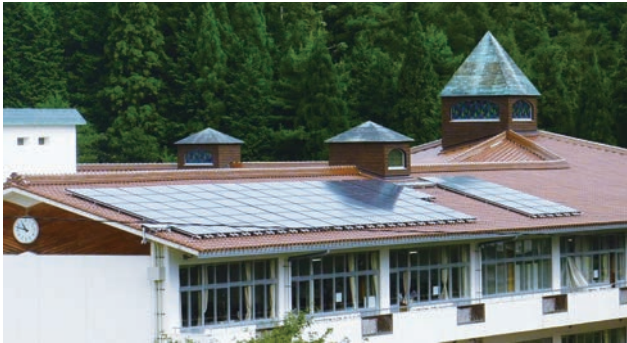
図5 来島小学校に設置された太陽電池
