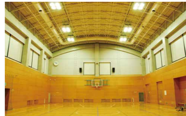
図4 LED照明を設置された川崎体育館
