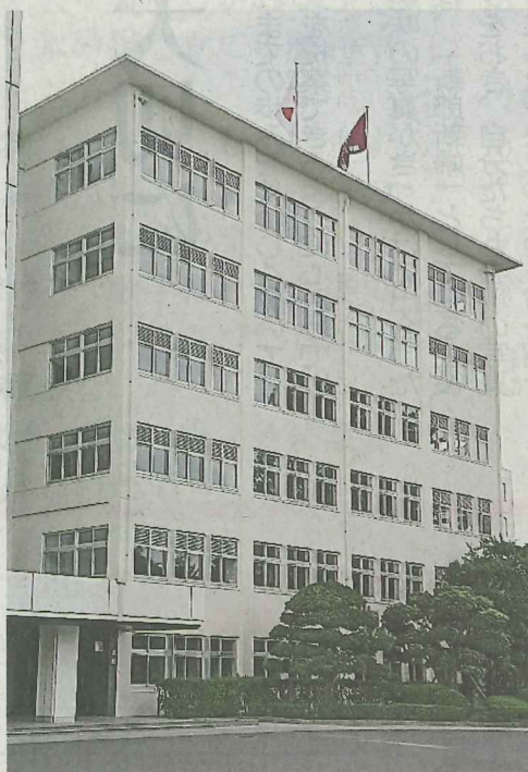
耐震補強工事が完了した本館
