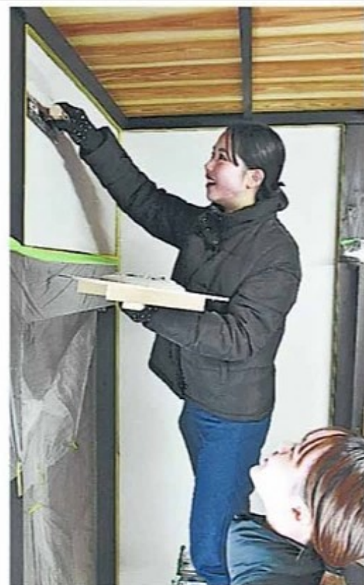
改修中の古民家の壁塗り作業をする広島工業大生
